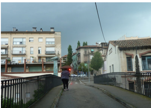
Una vista del pont de Santa Magdalena, amb les voreres encara per arreglar. Foto: J.C.
