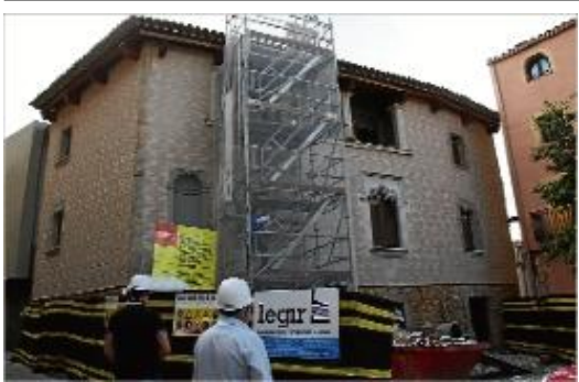
Els treballadors, acabant de remodelar la Casa de les Vídues.
