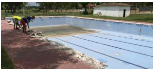
La piscina, en obres
