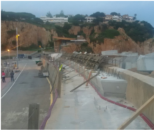
El banc de formig adossat al passeig de l'espatller del dic de recer, a mig encofrar Foto: E.A.
