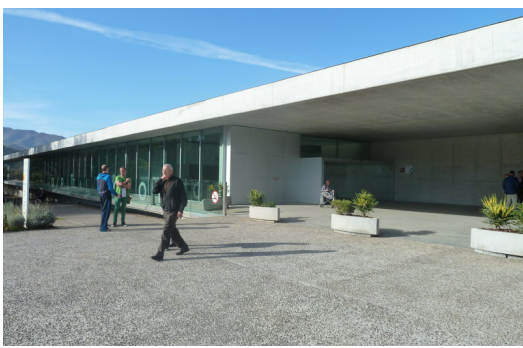
El nou hospital comarcal de la Garrotxa va incorporar novetats a la seva carpeta de serveis. Foto: J.C.
