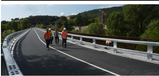
L'alcalde i un grup de tècnics donant l'última ullada a l'obra abans d'obrir el viaducte al trànsit, ahir al matí. Foto: R. E.
