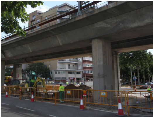
Operaris treballant sota el viaducte a Poeta Marquina, per fer el carril bici Foto: S. CABARROCAS.
