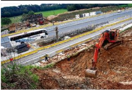
L'Estat inicia les obres per fer un pas de fauna a l'A-2 a Fornells
