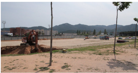
Moviments de terres, ahir a la tarda, a l'esplanada del futur recinte Guíxols Arena Foto: E.A.
