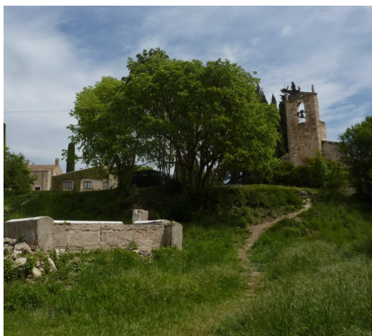
L'estructura del rentador, molt deteriorada, i al fons, l'església de Santa Maria de Porqueres. Foto: R. E.
