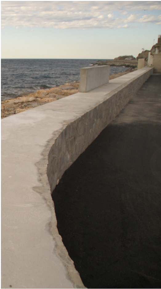
El nou tram del dic al Port de la Selva Foto: EPA.
