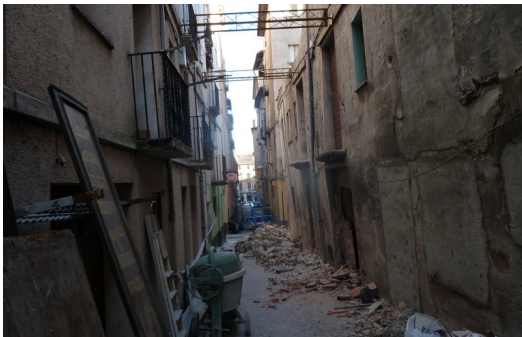
Una vista d'ahir a la tarda de l'edifici que s'està enderrocant al carrer Ferrerons. Foto: J.C.
