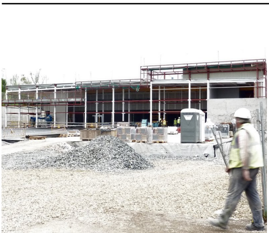
Detall de les obres del nou supermercat, ubicat al polígon de la Guardiola, ahir a la tarda. Foto: R. E.
