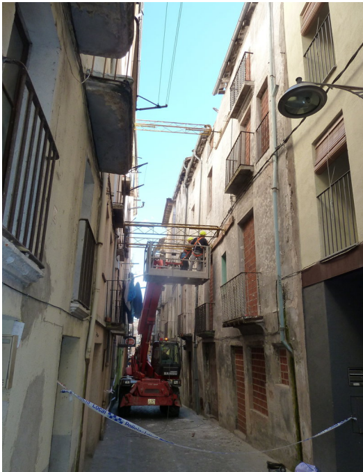
Una imatge dels treballs d'apuntament que es duen a terme ahir a la tarda. Foto: J.C.
