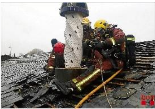
Un incendi de xemeneia afecta la teulada
