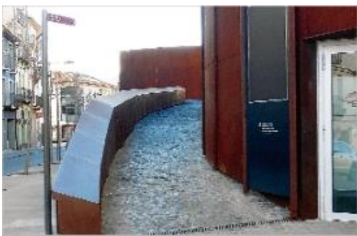
La barana d'acer de l'Arxiu Comarcal de la Garrotxa.
