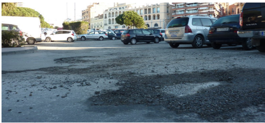
L'aparcament de la Planassa, on Romepark arranjarà el paviment en pocs dies Foto: E.A.
