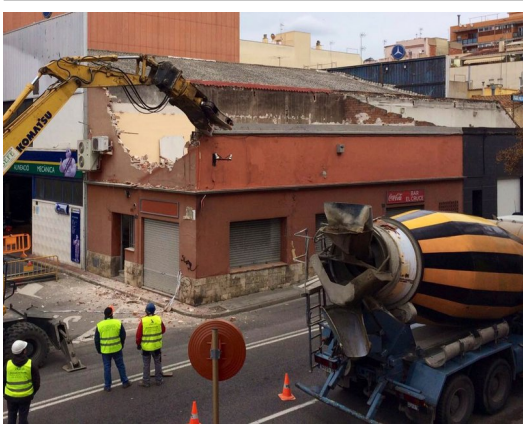
Els treballs d'enderroc van començar ahir. Foto: EL PUNT AVUI.
