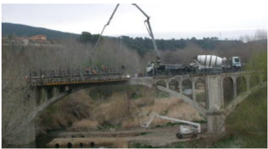
Els camions, treballant al Pont de Besalú.
