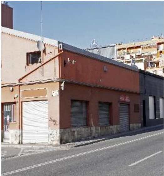
L'enderroc es farà a les finques 2 i 4 de l'avinguda Vila de Blanes.
