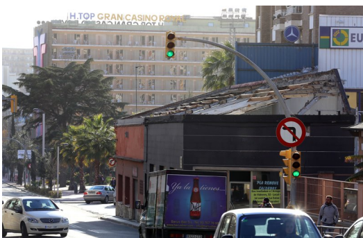
La teulada dels dos comerços que s'enderrocaran ja s'ha començat a retirar. Foto: QUIM PUIG.
