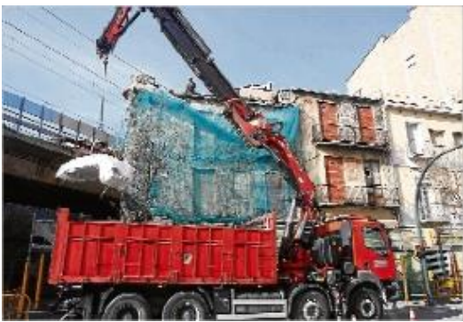
Comença l'enderroc d'un edifici degradat
