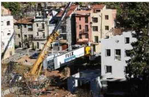
Un moment de la instal·lació de la caldera.
