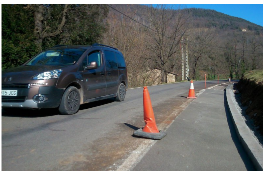
La cuneta americana de la carretera de la Pinya, que ha construït la Diputació. Foto: R. E.
