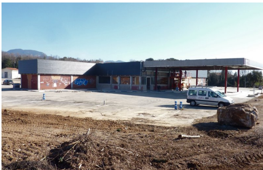
Estat actual de la gasolinera, on ja hi ha operaris treballant per condicionar-la. Foto: R. E.
