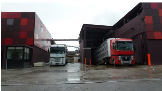
Els actuals molls on descarreguen els porcs els camions, en una vista de les instal·lacions des del l'avinguda Europa. Foto: J.C.
