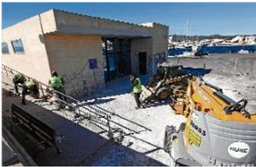
L'estació marítima, en obres aquest dilluns.
