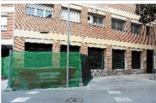
Un dels espais en obres a l'estructura de l'antic hospital.
