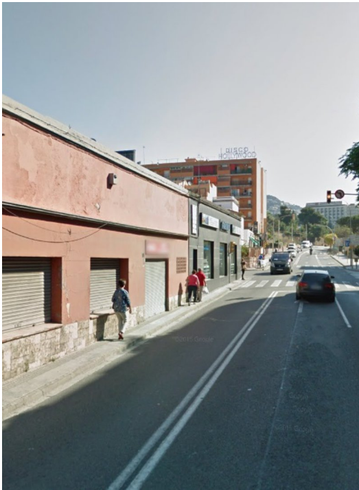
Les edificacions que s'han d'enderrocar, a l'esquerra, en una imatge d'arxiu. Foto: EL PUNT AVUI.
