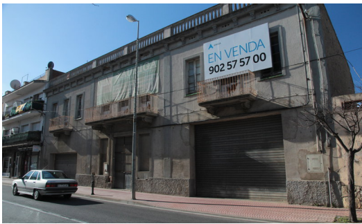
L'edifici de l'antic ajuntament de Sant Joan de Palamós, actualment en venda Foto: E.A.
