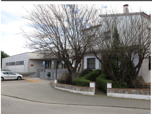
La futura casa d'emergència de Vidreres, al costat del CAP, fa uns dies Foto: JOAN SABATER.
