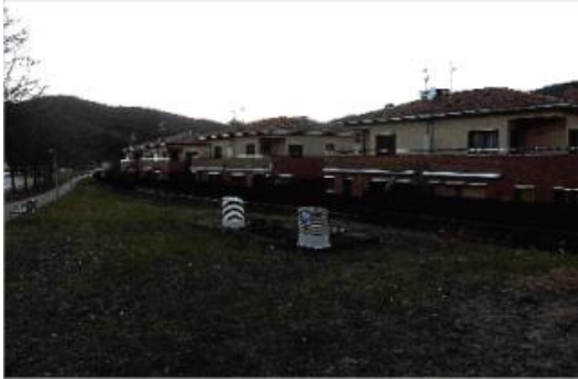
Centre de transformació elèctrica ubicat al Pla de Dalt, ahir a la tarda.
