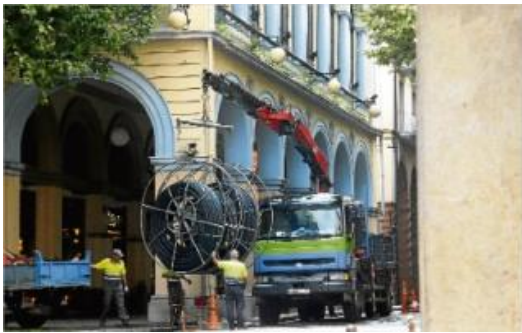
Treballs de col·locació de la xarxa de fibra òptica al centre d'Olot.
