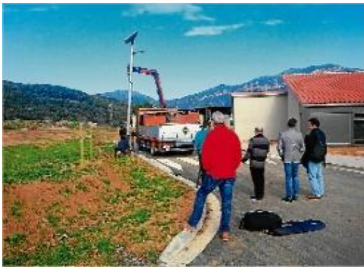
Un moment de la instal·lació del fanal autosuficient.
