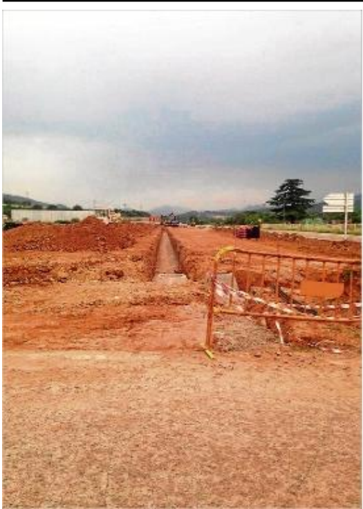
Aspecte de les obres del polígon que necessitarà de la planta.
