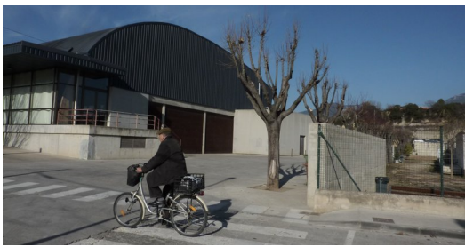
L'espai entre el pavelló i l'escola, que és el lloc on posaran la caldera de biomassa. Foto: R. E.
