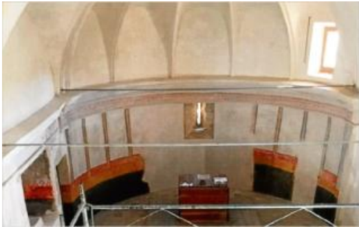
Interior de l'església de Sant Martí de Capellada, durant les feines de restauració.
