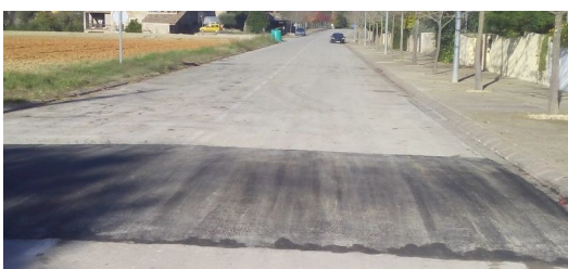
Un dels ressalts que s'han arreglat Foto: EPA.
