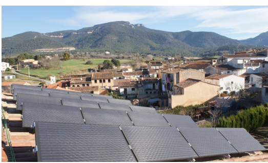
Una vista de les plaques, instal·lades de forma horitzontal per evitar l'impacte visual. Foto: J.C.
