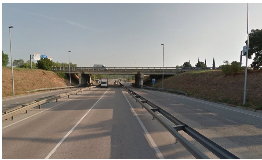
L'enllaç de Vidreres de l'N-II amb la carretera C-35, que està pendent de les obres de remodelació. Foto: EL PUNT AVUI.
