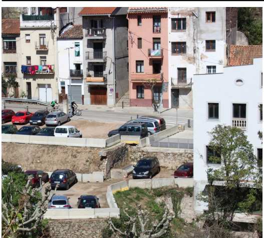
La caldera anirà instal·lada just al darrera de l'edifici de Can Delfin i permetrà estalviar 873.000 litres de gasoil. Foto: J.F.
