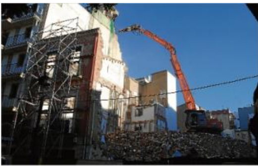
Comença la demolició de l'hotel Rex ganxó
