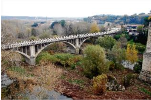
Els 210 metres del pont de Besalú sobre el Fluvià seran objecte de millora.
