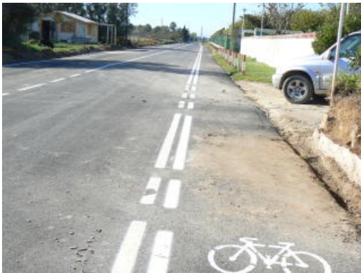
L'asfaltatge de la carretera de la platja
