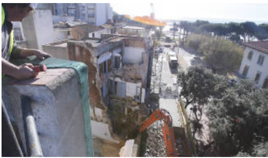
Enderroquen part del llegat dels Anlló
