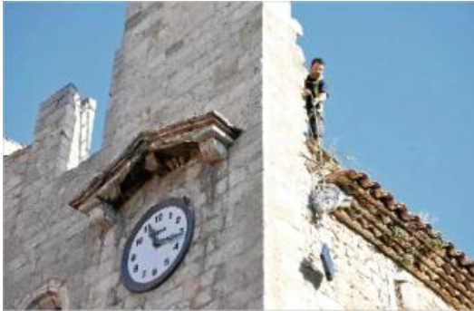
Un operari, durant les tasques per substituir el sistema de funcionament del rellotge i les campanes.
