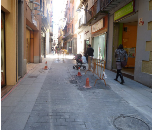
Les obres del carrer Major. Foto: J.C.
