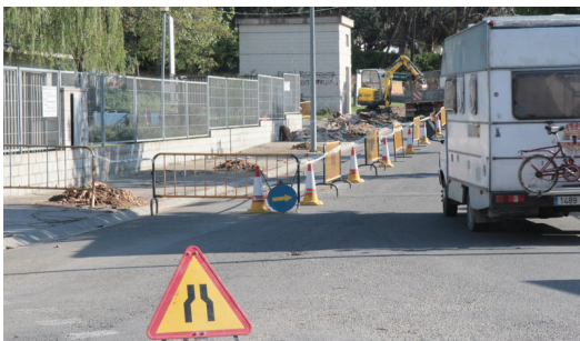
Les obres del nou tram de carril bici al carrer Rafel Savalls del polígon de Sant Joan Foto: E.A.
