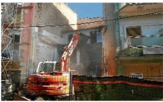
L'excavadora, ahir, enderroca part de l'hotel Les Noies.
