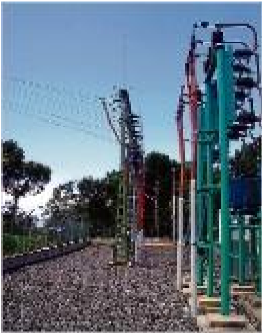
La nova instal·lació.
